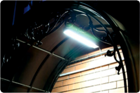
GSU-40. Освещение двора жилого дома.
